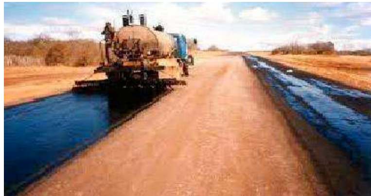
Imagem: Imprimação asfáltica
