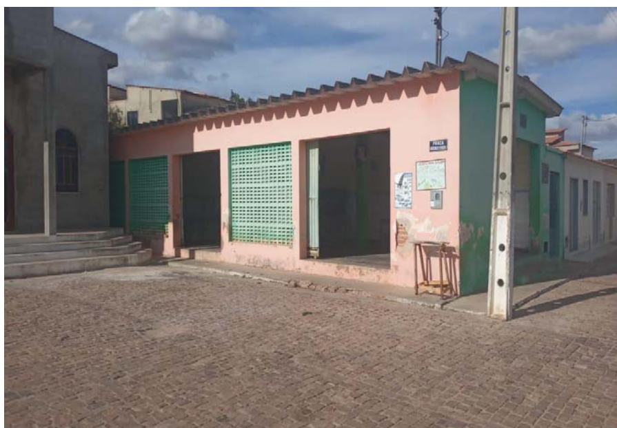
Foto 01 - Vista da Rua em Frente da Igreja – Mercado a ser demolido ao lado
