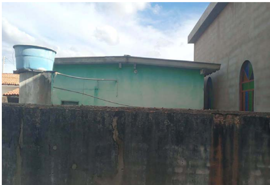
Foto 05 – Vista do muro do fundo
